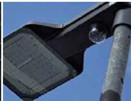
mastap-Monitoringverfahren - Schwingungssensor integriert im Leuchtkörper.
